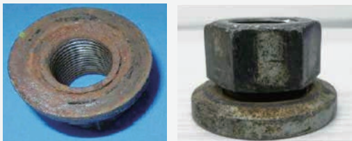
劣化がひどいものは交換しましょう
