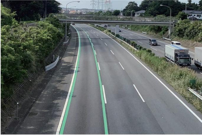
2021年7月に関越自動車道に初めて設置された「車線キープグリーンライン」。これは、NEXCO独自の試行的な取り組みでキープレフトの促進による渋滞予防やICからの流入する車の逆走対策を目的として設置されました。設置から1年、施行前と比較して67~76%車線変更回数が減少し、渋滞緩和に効果があったようです。
